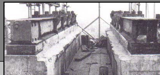
Travi in ferro utilizzate da Balanos sull'estradosso delle travi in marmo sul soffitto del portico nord delle Cariatidi
