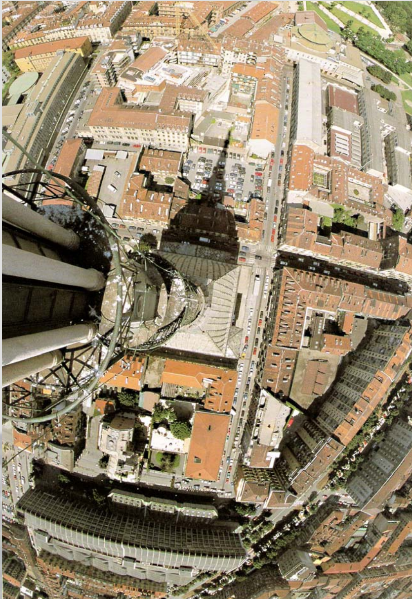
Visione dall'alto della Mole ripresa dall'ultimo ballatoio sottostante la stella alla sommità della guglia.
